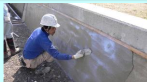
老朽化した水路壁のコーティング
