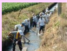
水路の泥上げ
