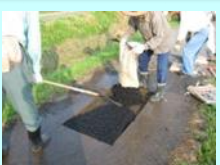
農道の部分補修
