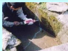
水路のひび割れ補修
