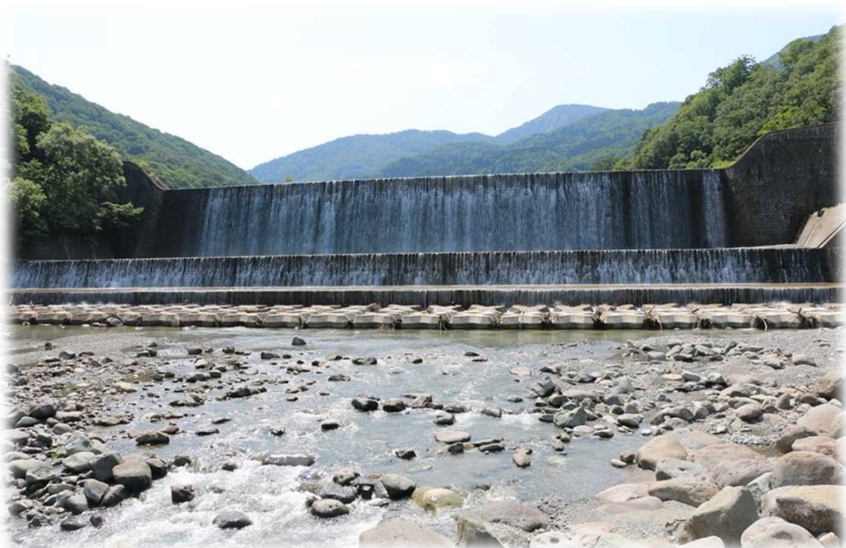
国の登録有形文化財となった「六瀬砂防堰堤」
