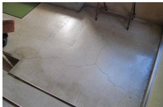
【大きく亀裂の入った廊下】
