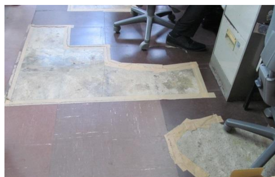
【傾き、剥離した事務室の床】
