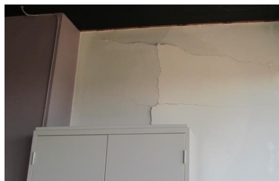
【ひび割れた内壁】
