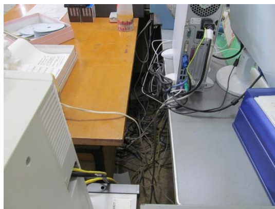
【露出している配線】
