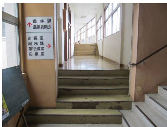
【段差のある通路】
