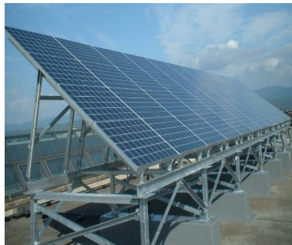
響ホールの太陽光発電
