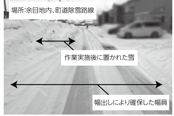
場所:余目地内、町道除雪路線 作業実施後に置かれた雪 幅出しにより確保した幅員 通行に支障のない幅員の確保に努めますが、このように幅出しなどの作業実施後に道路上への投雪が確認される場所があります。
