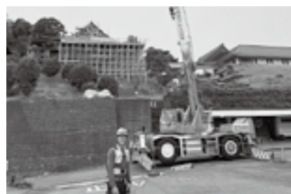
△現在施工中の静岡の現場
