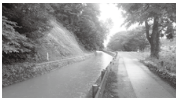
水路復旧完了、斜面工事継続
