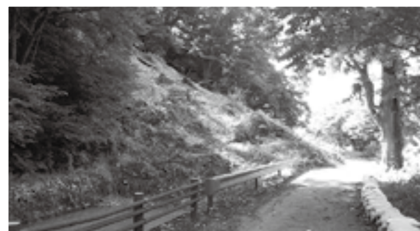
土砂崩れによる北楯大堰の閉塞（清川地内）
