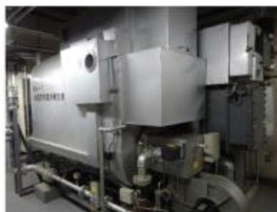
図1-1 RH-1 吸収式冷温水発生機
