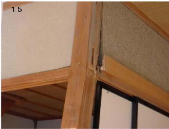
柱の破損
