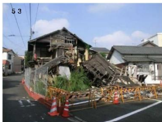
既に一部崩壊している
