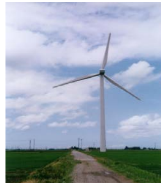
*1500kW 風車(町営)
