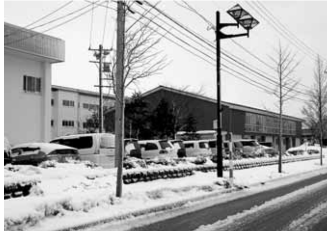
工事は全て完了（立川小学校）
