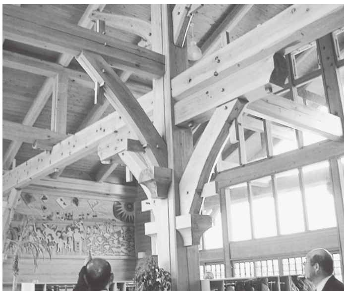
▲木組み、木製サッシが目を見張ります (三川町東郷小学校)
