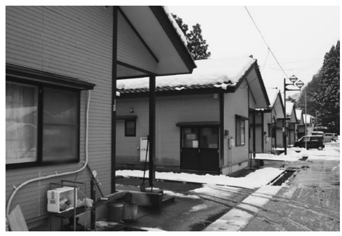
▲定住促進に不可欠な町営住宅（清川）
