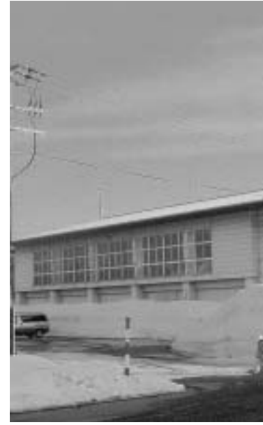
屋根改修が完了
