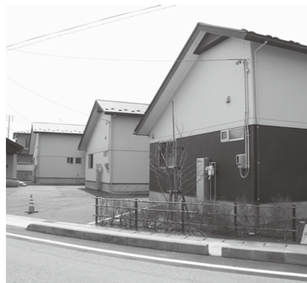
▲若者定住促進住宅(松陽地内)
