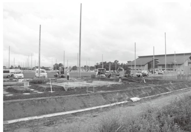
着々と工事の進む八幡スポーツ公園
