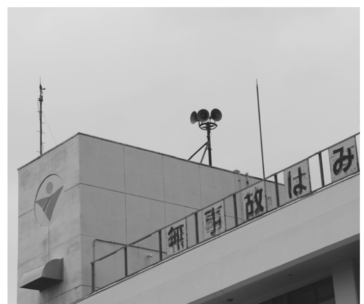
防災無線はデジタル化を全町に拡大
