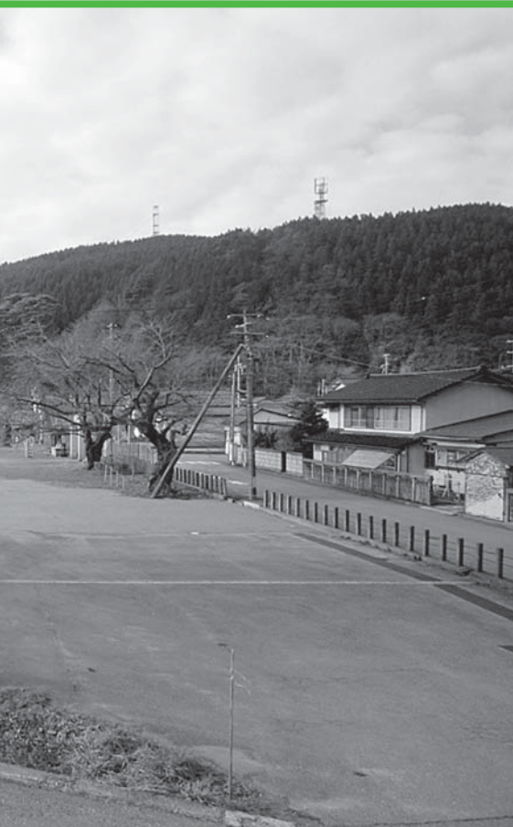
旧清川小学校跡地
