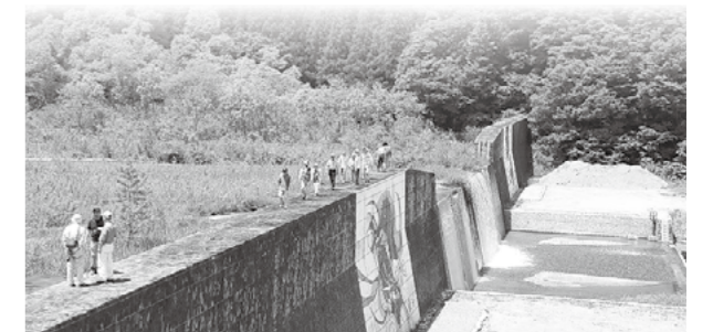
▲玉川第六砂防堰堤の上を探検
