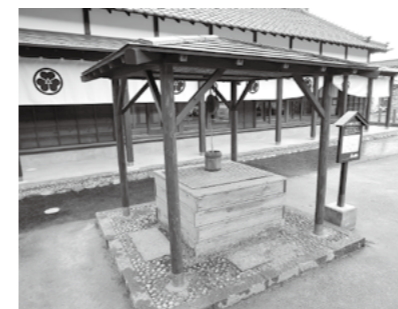
▲補修された井戸
