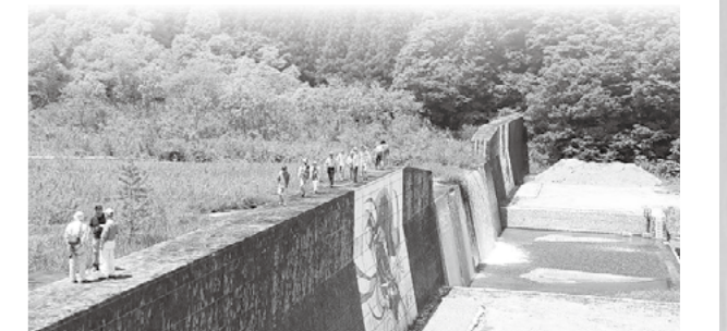
▲玉川第六砂防堰堤の上を探検
