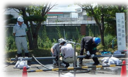
防災訓練「水道施設応急復旧訓練」
