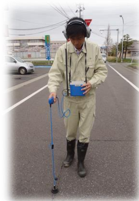
本管漏水調査
